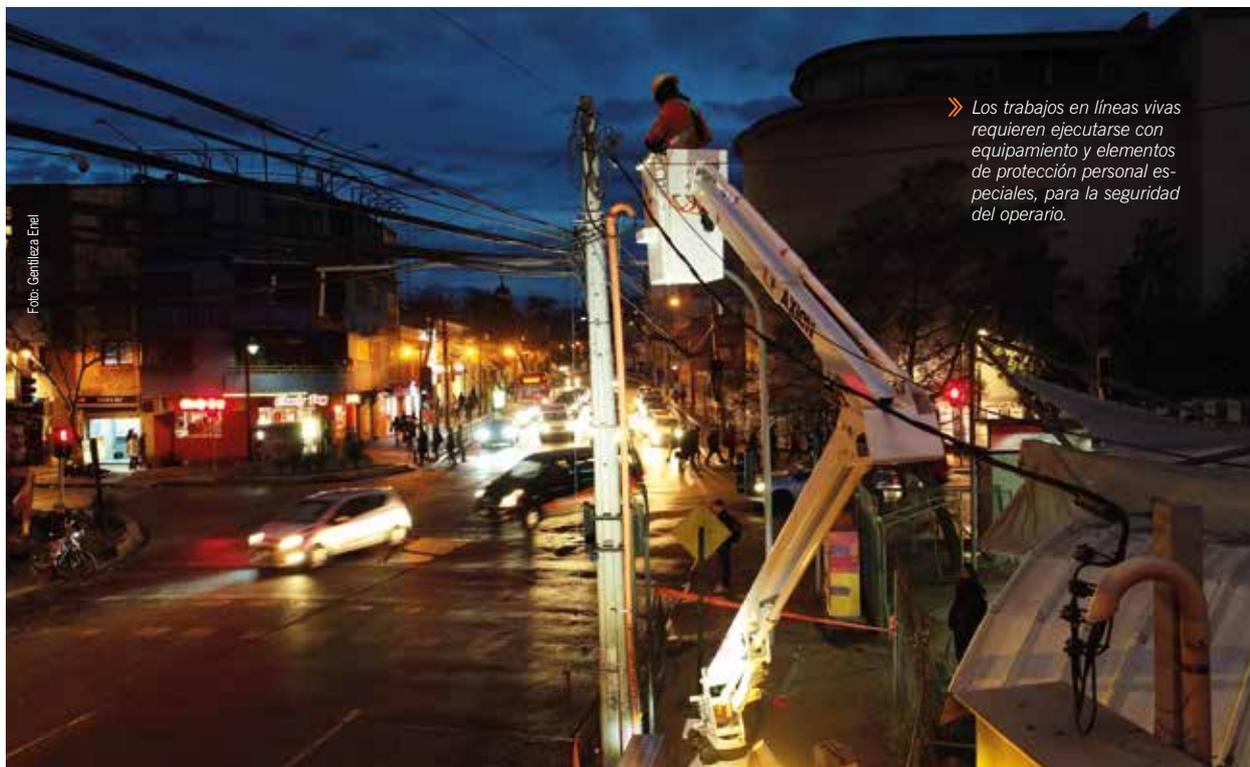
» Los trabajos en líneas vivas requieren ejecutarse con equipamiento y elementos de protección personal especiales, para la seguridad del operario.
